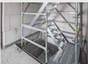
Bau- und Ausbautreppen
