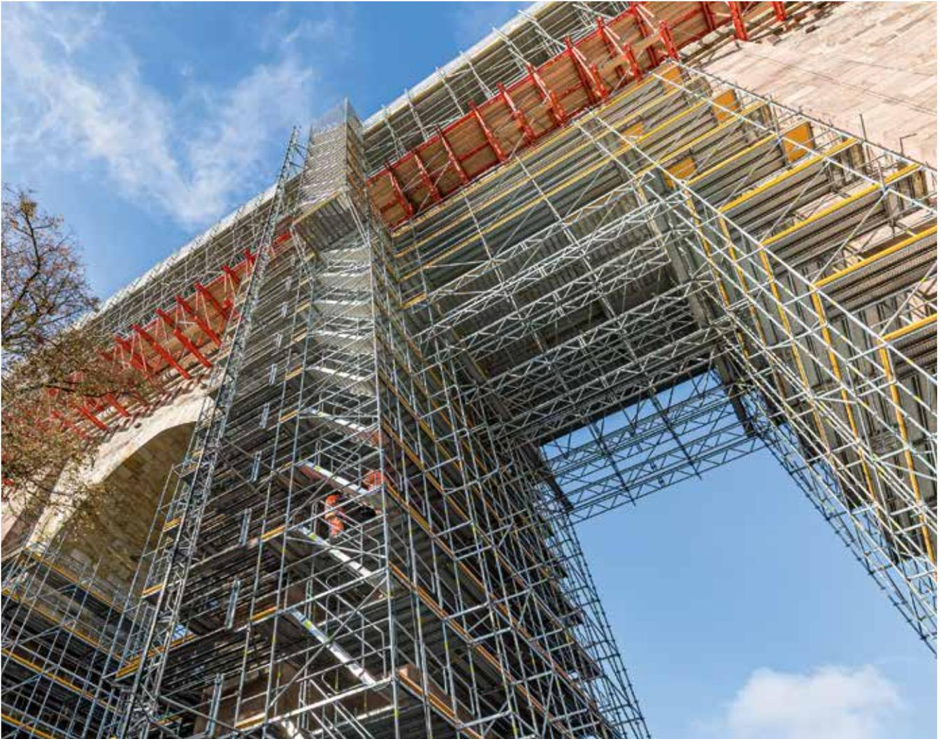
**Bei der Sanierung eines historischen Viadukts bringt die kombinierte Verwendung von Gerüst und Ingenieurbauteilen aus einer Hand große Montagevorteile. Das PERI UP Gerüstsystem in Verbindung mit Kernbauteilen des VARIOKIT Ingenieurbaustens macht mit dem vielseitigen Einsatz als Tragkonstruktion sowie Stand- und Hängegerüst auch äußerst komplexe Gerüstlösungen möglich.**
