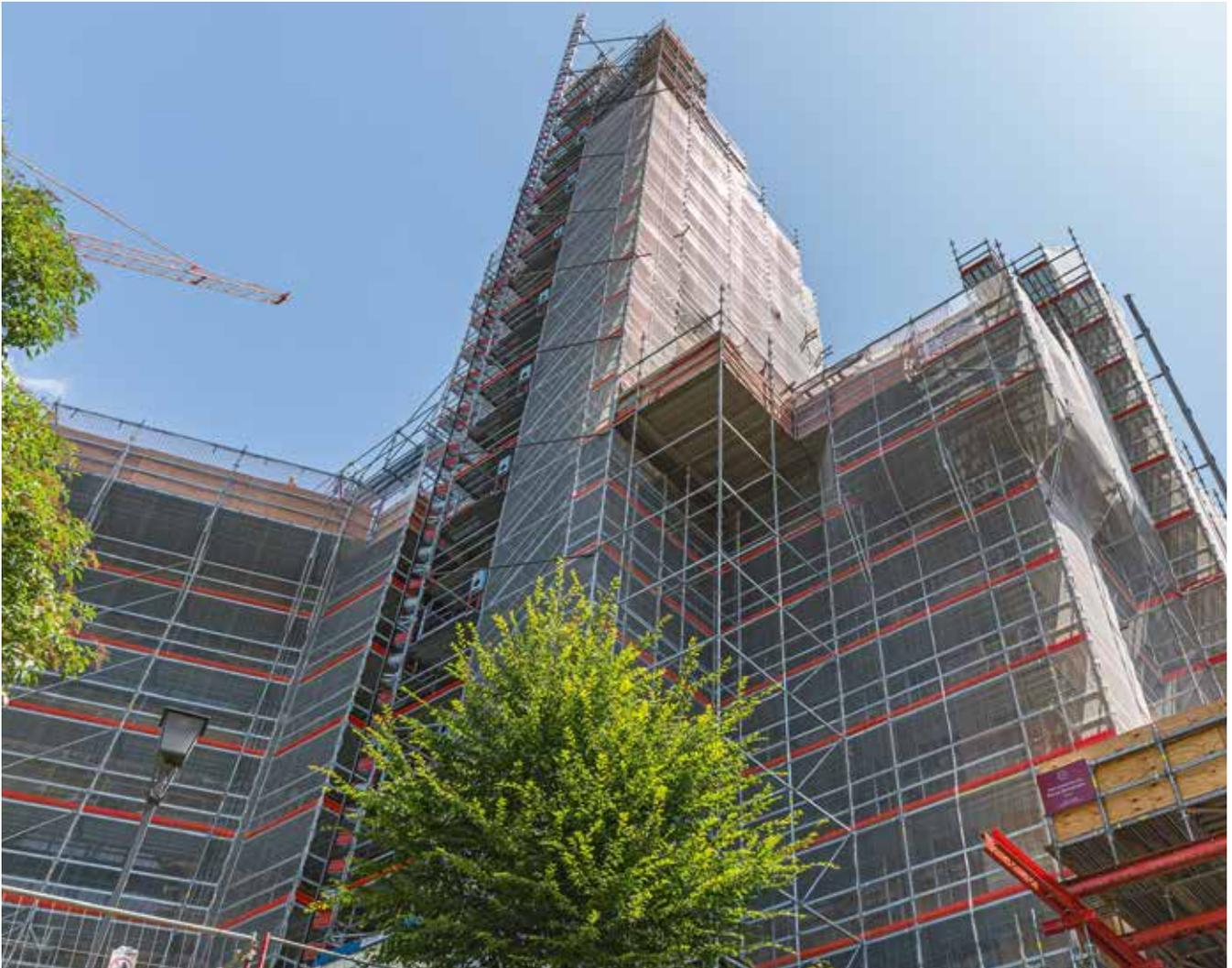
**Bei der Einrüstung der Bamberger Stephanskirche sorgte die konsequente Verwendung von Systembauteilen und die Kombinationsfähigkeit der Baukastensysteme PERI UP und VARIOKIT für Zeit- und Kostenvorteile sowie durchgehend hohe Sicherheit.**
