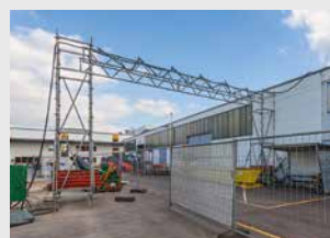
Kabelbrücken
