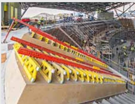
Auch die Deckenelemente waren wichtiger Bestandteil der PERI Komplettlösung.
