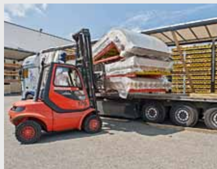
Die passend konfektionierten Maßelemente wurden entsprechend dem Bauablauf just-in-time und in maximaler Qualität auf die Baustelle geliefert.
