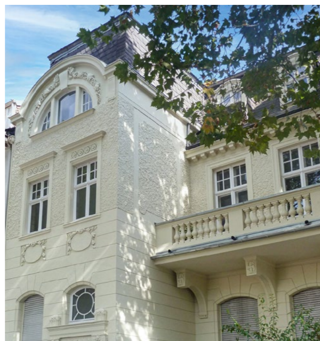
Foto: Kratz Bauunternehmung GmbH, Bonn
