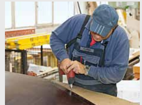
Betonoberfläche ohne Niet- oder Schraubenabdrücke: Sparschalung und erste Schalhautlage wurden verschraubt, danach die zweite Schalhaut aufgeklebt.
