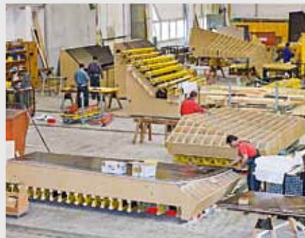
Die stationäre Vorfertigung mit modernster Anlagentechnik und von ausgebildetem Fachpersonal sorgt für hohe Qualität.
