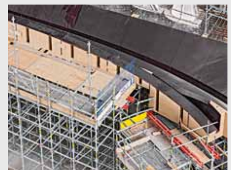
Unterstützt durch ein PERI UP Trag- und Arbeitsgerüst ließen sich die über 200 Maßelemente vor Ort zur 3D-Gesamtschalung montieren.
