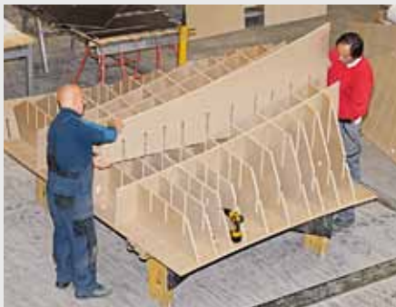
Die 3D-Schalungselemente wurden von PERI fix und fertig vormontiert – mithilfe der Formknaggen aus der CNC Holzbearbeitungsanlage.
